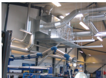
Autoindustri; Sydjysk Lastvognsservice Ventilation 8.000m³/h
