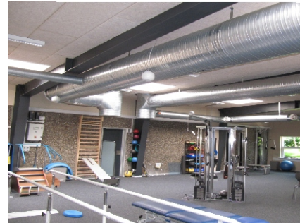
Motionscenter: Varde Fysioterapi & Træningscenter Komfortventilation 8.000m³/h
