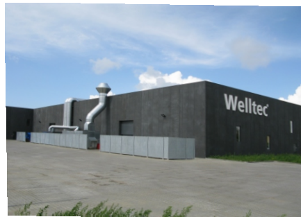
Offshoreindustri: Welltec, Esbjerg Rumventilation 30.000m³/h
