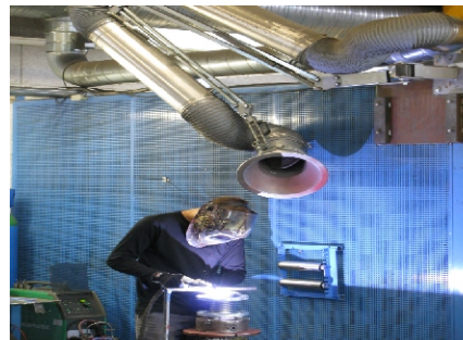
Metalindustri: Shape Tech, Esbjerg Svejsersugsudsug 18.000m³/h
