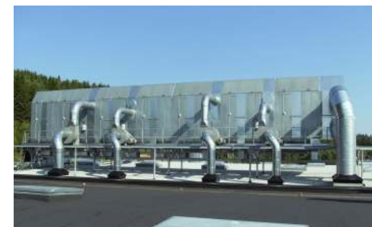
Samlet procesluftkanal eksplosion aflastning - ATEX
