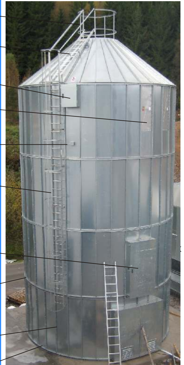
Silo med fyrrum og mellembund under opførelse
