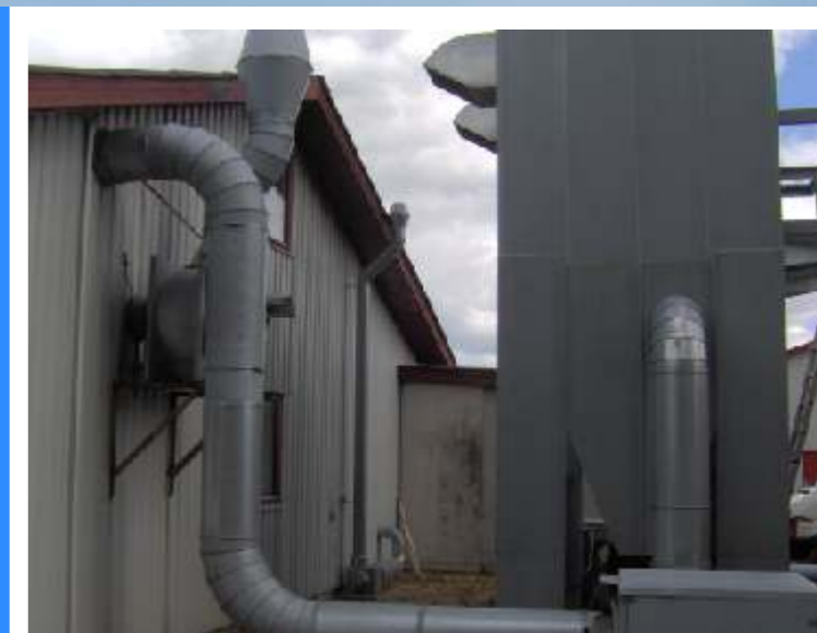
Udblæsningsrør til det fri
